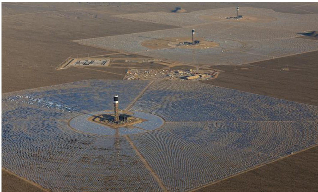
Figura 14. Planta Termo Solar Ivanpah
